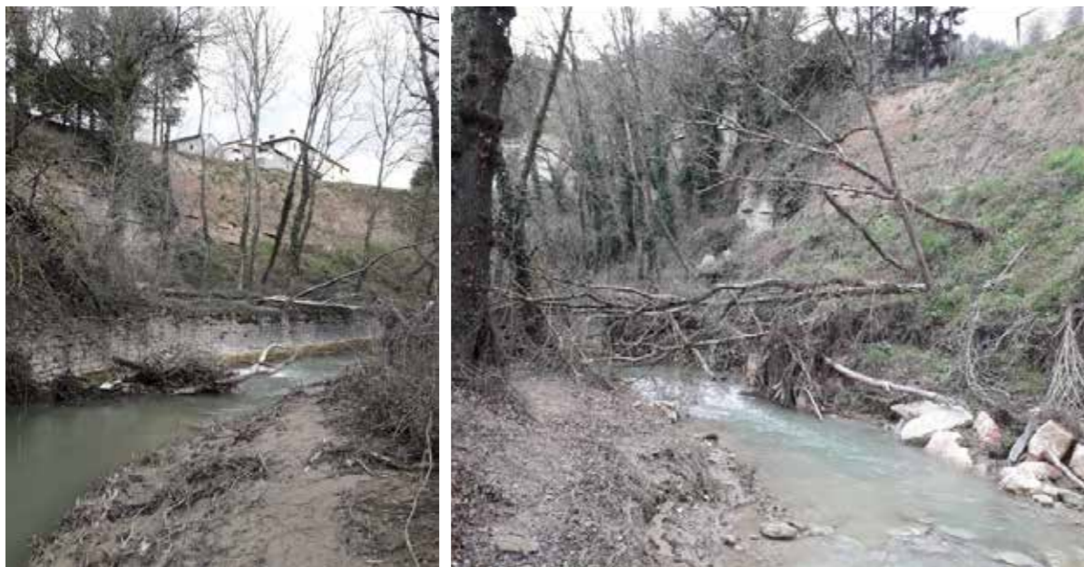
Figure 3.3, 3.4: frane e erosione delle sponde da un sopralluogo a dieci giorni dall'evento. Nelle foto risulta evidente il ruolo della vegetazione non mantenuta lungo le sponde, così come la presenza di edifici proprio a monte della frana.
